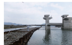
東日本大震災津波に耐えた 岩手県織笠川水門二重鋼矢板補強工
