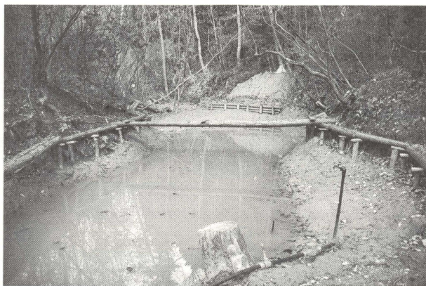
写真4. 完成した水場2
