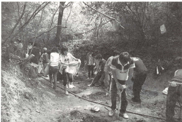
写真3. 学生等による水場2の創成過程
