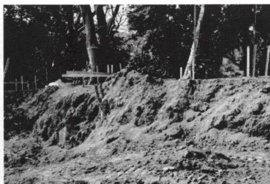
小石川植物園御殿坂側の工事
