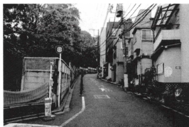
小石川植物園脇の御殿坂－工事前
