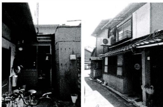
(左) 写真1 既存物件を簡易宿所に転用している (右) 写真2 路地奥の建物であっても簡易宿所に改修されている
