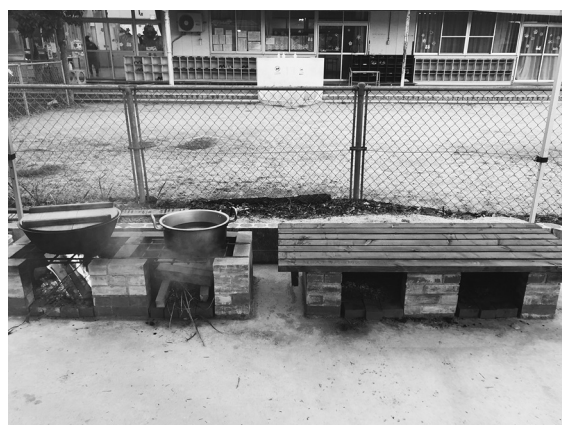
図11 「防災かまどベンチ」の製作の様子と完成した「防災かまどベンチ」
