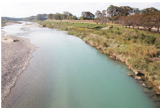
写真7 葉枝見橋 砂礫州消失 (上流から下流方向に撮影 2018/10/19)
