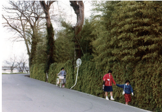
写真2 桂川右岸堤防の笹垣（撮影：大熊）
