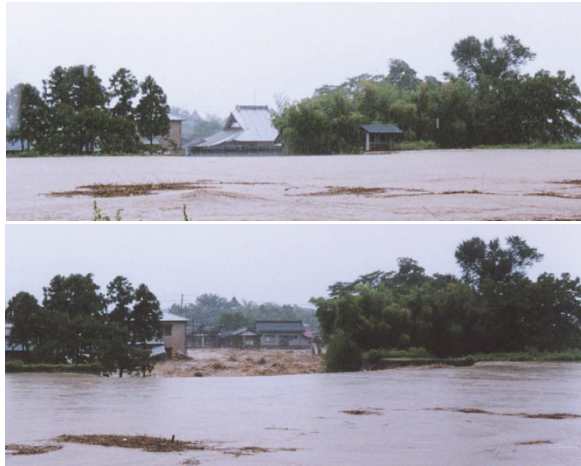
写真1 新潟水害・刈谷田川中之島（左岸）の破堤 （上・破堤直前、下・破堤直後）（撮影：石橋栄治）
