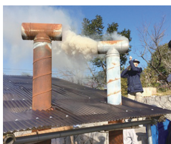
図19 右の窯使用：T字型の煙突から出る白煙、水蒸気である。
