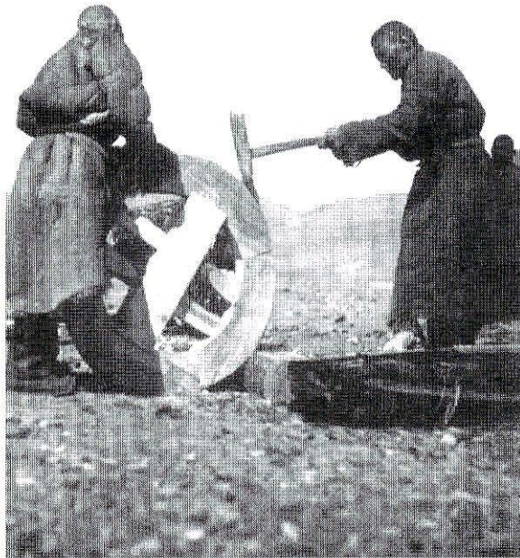
図四 20世紀初頭、モンゴル国ハンガイ山地区における車輪（Ba式）製作風景
