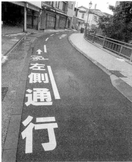
(1) 自転車走行指導帯の整備により、車道左側通行を促している。
