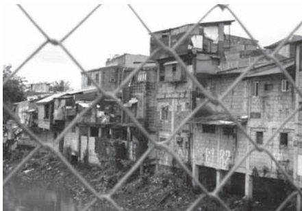
写真5 川沿いに密集して立てられた家
