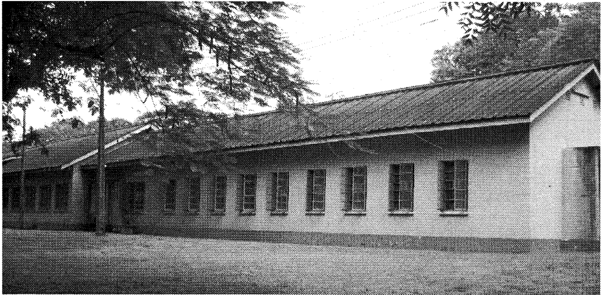
図3 アロ病院薬物病棟
